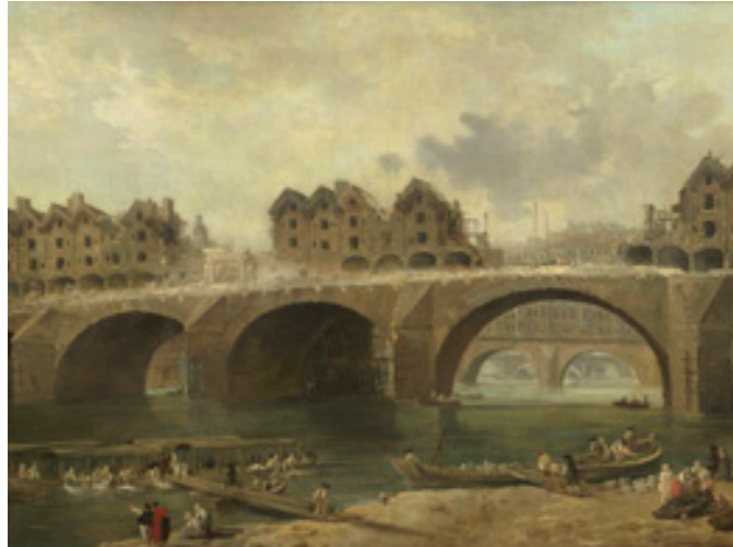
Hubert Robert, La Démolition des maisons du pont Notre-Dame, en 1786, huile sur toile © RMN-Grand Palais (musée du Louvre)/Hervé Lewandowski
