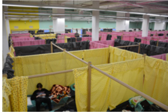
Système PPS (« paper tube partition system ») imaginé par Shigeru Ban, hébergement d'urgence pour les réfugiés ukrainiens, ancien hypermarché Tesco, Chelm (Pologne), mars 2022 © Jerzy Łatkas
