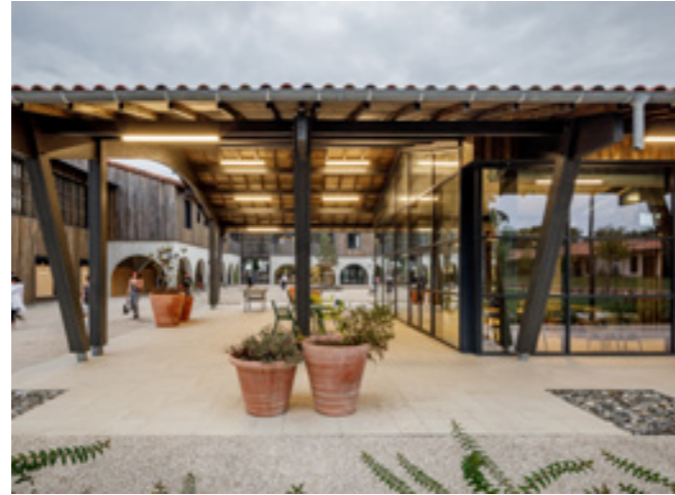
Village Alzheimer de Dax, Nord Architects et Champagnat & Grégoire architectes, 2016-2020 © 11h45 Photographie d'architecture
