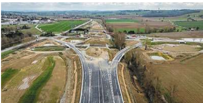
Chantier de l'A69 près de Verfeil (Haute-Garonne), vendredi. | PHOTO : ED.JONES, AFP
